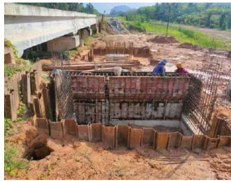
รูปที่ 2-27 การจัดทำแนวกำแพงกันดิน (Sheet Pile)
