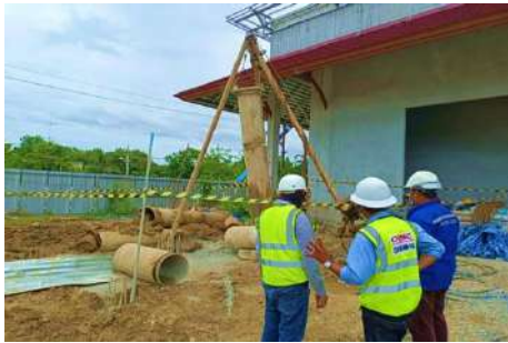
เสาเข็มเจาะ ฐานราก Radio Tower
