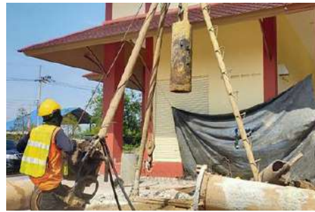
เสาเข็มเจาะ ฐานราก Radio Tower
