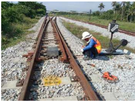
งาน Re-Survey Marking Out IRJ
